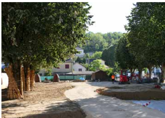
► Désimperméabilisation, aménagements et plantations : les cours se sont transformées au fil du chantier.
